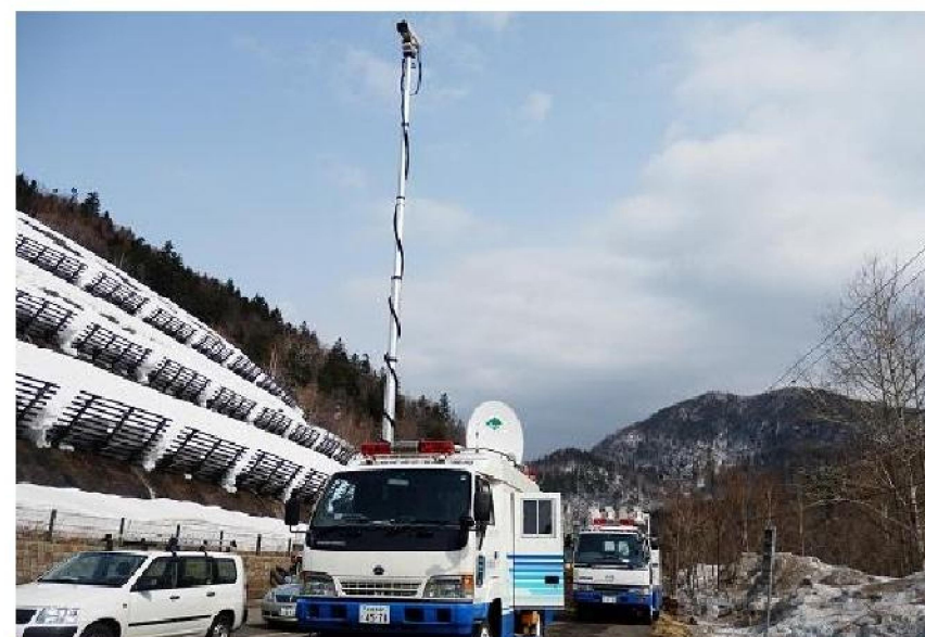
H25.4 一般国道230号 地盤変状による出動〔札幌市〕
