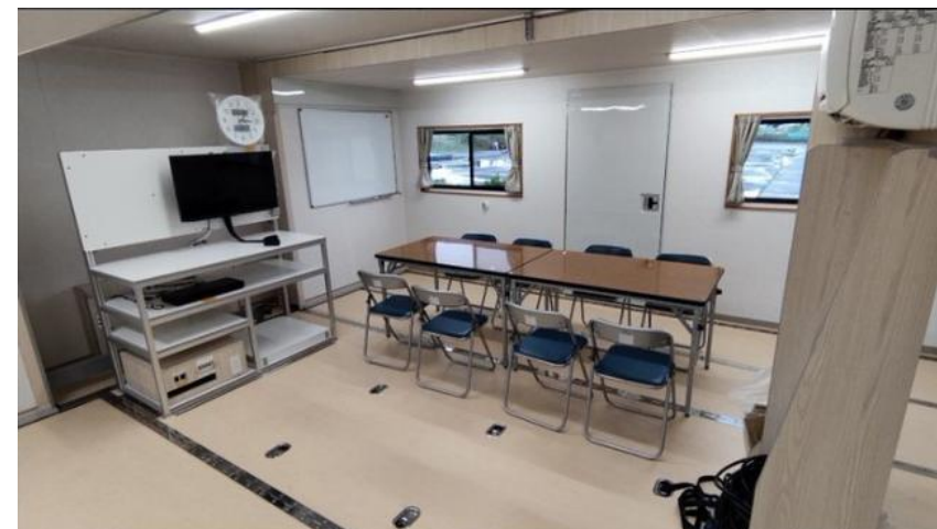
車両後部拡幅時の会議スペース
