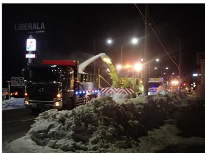
運搬排雪作業 （国道 38 号 帯広市）
