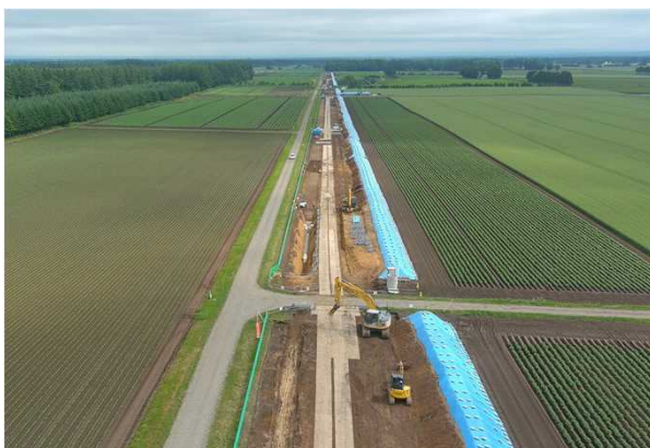
整備中の用水路（芽室川西地区）
