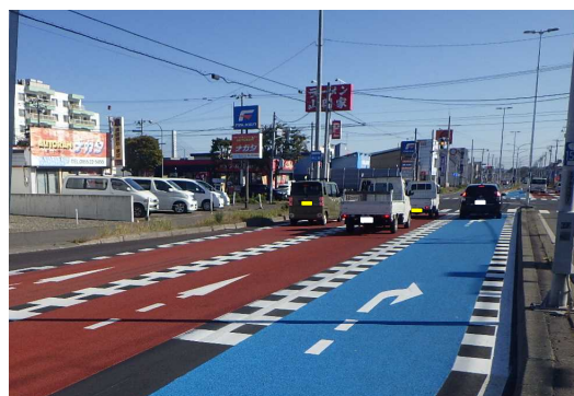
車線の明確化による事故対策 (国道38号 帯広市西7条)
