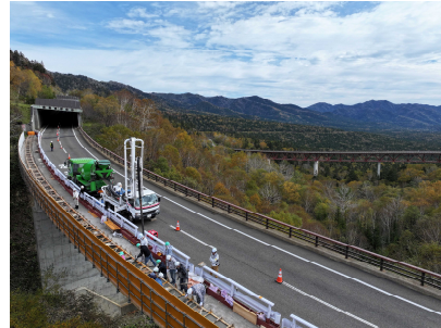
橋梁補修状況 （国道 273 号 コマクサ橋）
