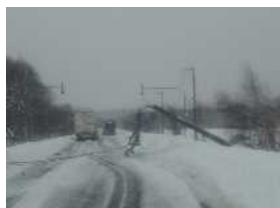
暴風雪による電柱の倒壊 (国道336号 大樹町)
