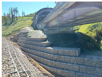
河川に隣接する道路構造物の流失防止等の対策 (国道274号 清水町)
