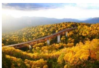
国道273号 三国峠 (松見大橋)
