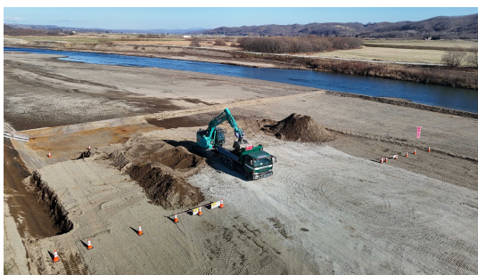
▲河道掘削の状況
