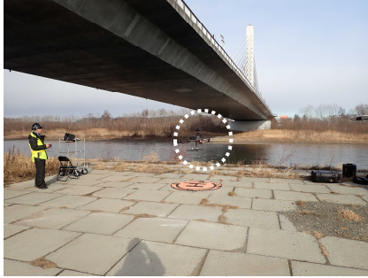
ドローンによる橋梁の点検状況 （国道 241 号 十勝大橋）
