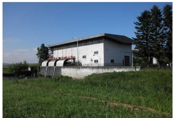
整備予定の排水機場（新川二期地区）
