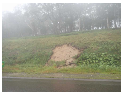
法面・盛土の防災対策 (国道274号 清水町)
