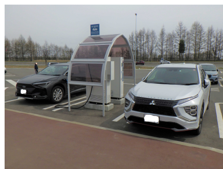
急速EV充電施設の設置 道の駅「おとふけ」
