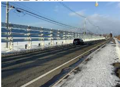
防雪柵設置 （国道 274 号 鹿追町）
