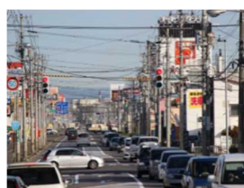
電柱・電線による景観阻害 (国道241号 音更町)
