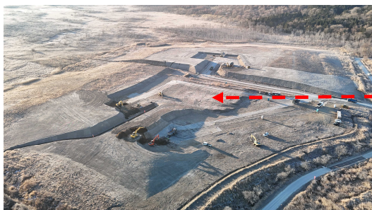
▲一時避難場所の造成状況
