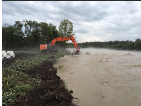
クレーン装置付バックホウを配置しブロックを投入
