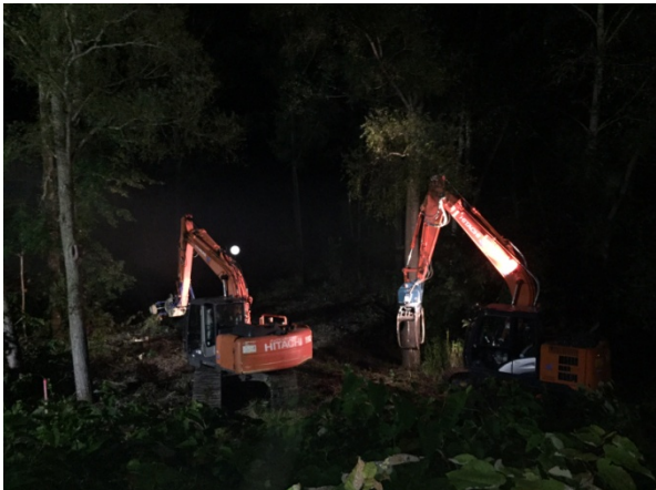
進入路設置状況(作業開始)
