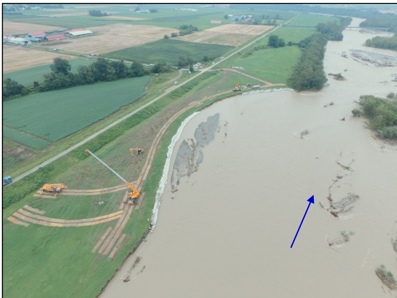
応急対策中の状況(空撮)
