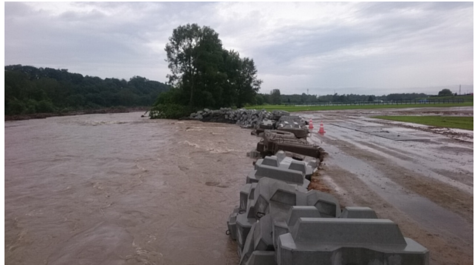
応急対策状況
