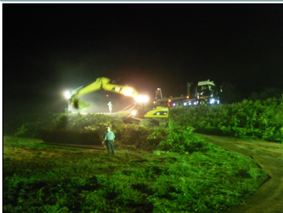
進入路設置状況(作業開始)
