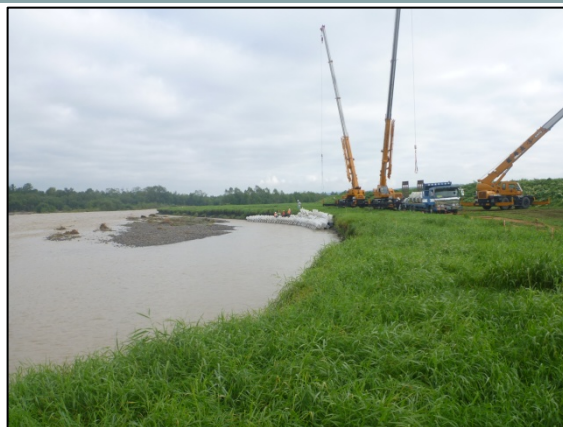
クレーン3台を配置しブロックを投入
