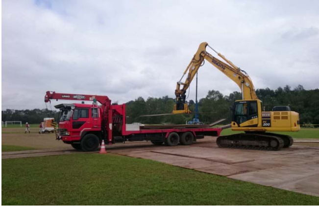
進入路設置状況(作業開始)
