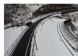
復旧工事完了
