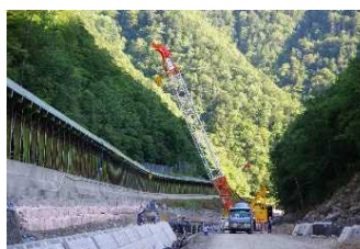
基礎復旧工事完了
