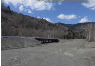
仮橋架設完了
