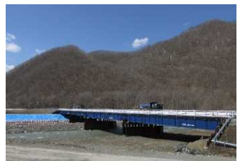
仮橋架設完了
