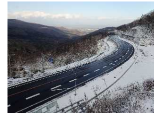
復旧工事完了
