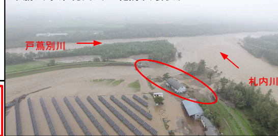
十勝川水系札内川の堤防決壊状況
