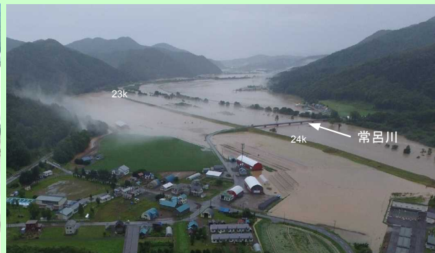
常呂川水系常呂川 堤防越水等による氾濫状況
