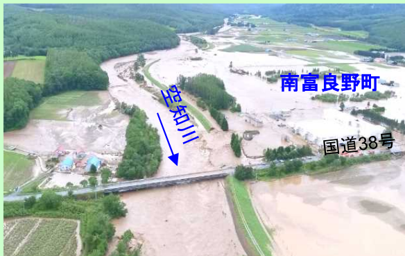
石狩川水系空知川 堤防決壊等による氾濫状況
