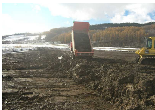
土砂が流出した農地へ運搬し、
