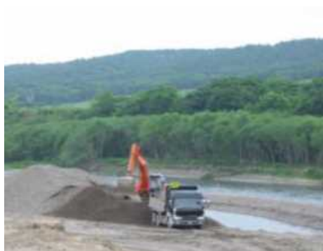
河道掘削した土砂を、
