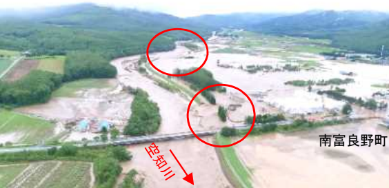
石狩川水系空知川の堤防決壊状況
