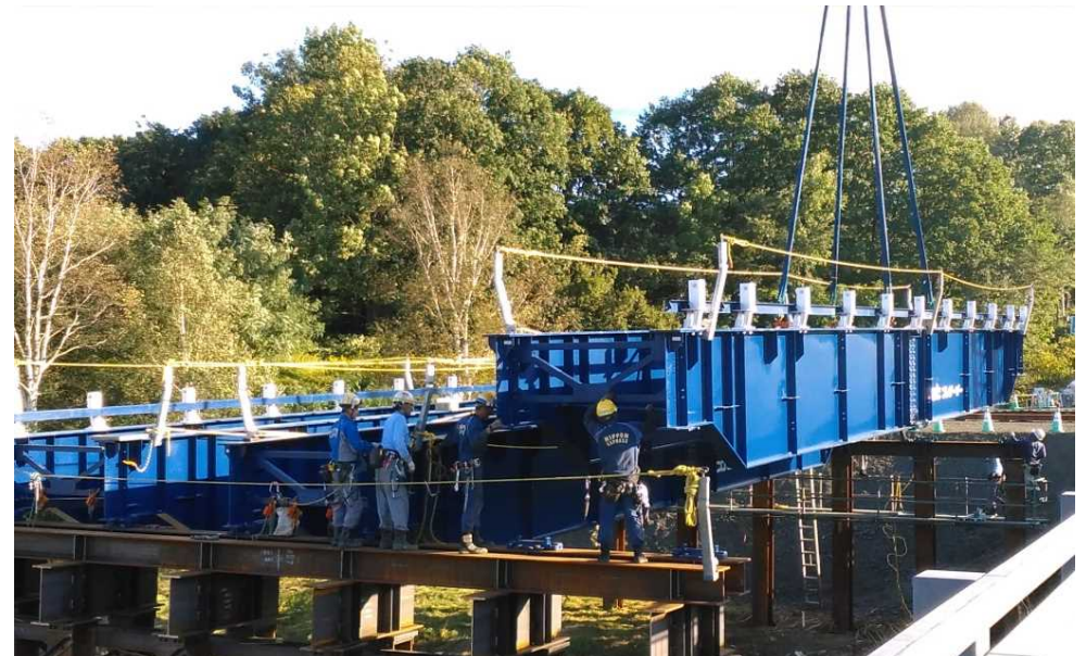
復旧状況【昼間】 ～クレーンによる仮橋設置状況～
