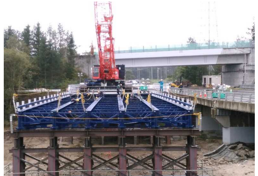
復旧状況【昼間】 ～クレーンによる仮橋設置状況～
