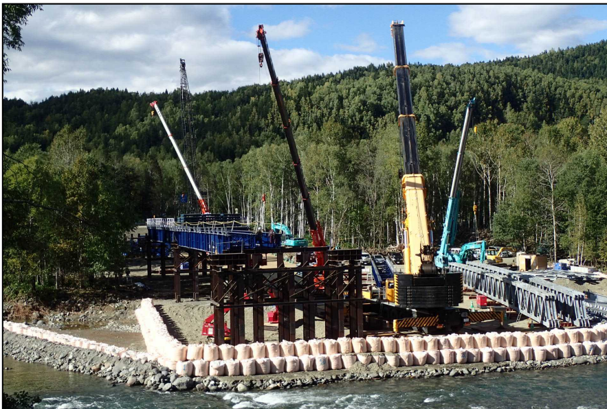
復旧状況【昼間】 ～仮橋 上部工架設～
