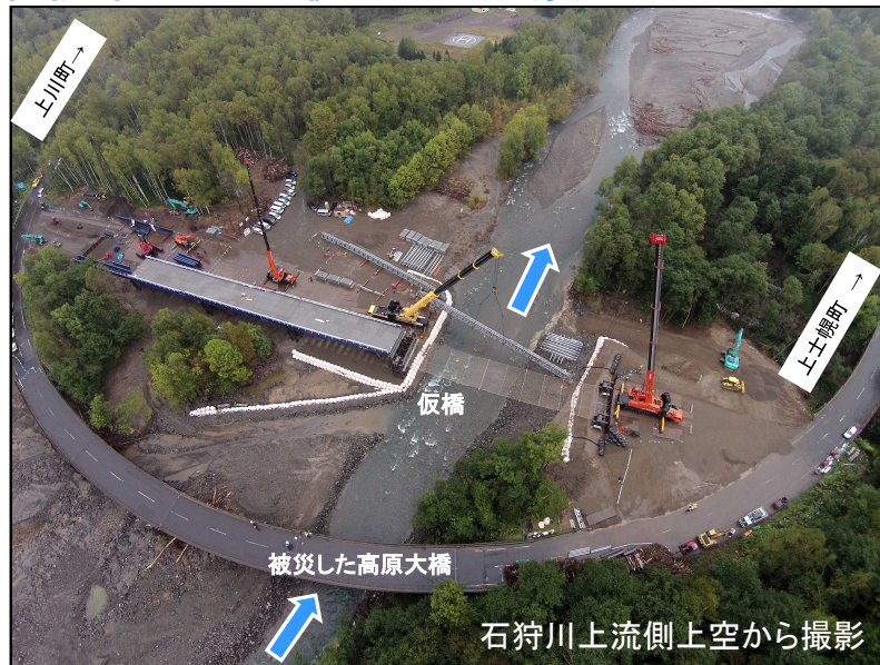
復旧状況【昼間】 ～仮橋 上部工架設～
