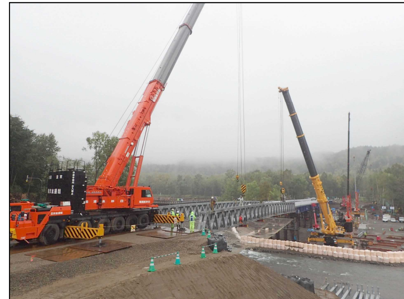
復旧状況【昼間】 ～仮橋 上部工架設～
