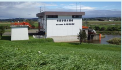
育素多排水機場
