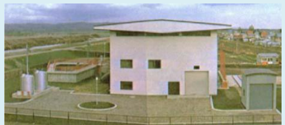
帯広排水機場
