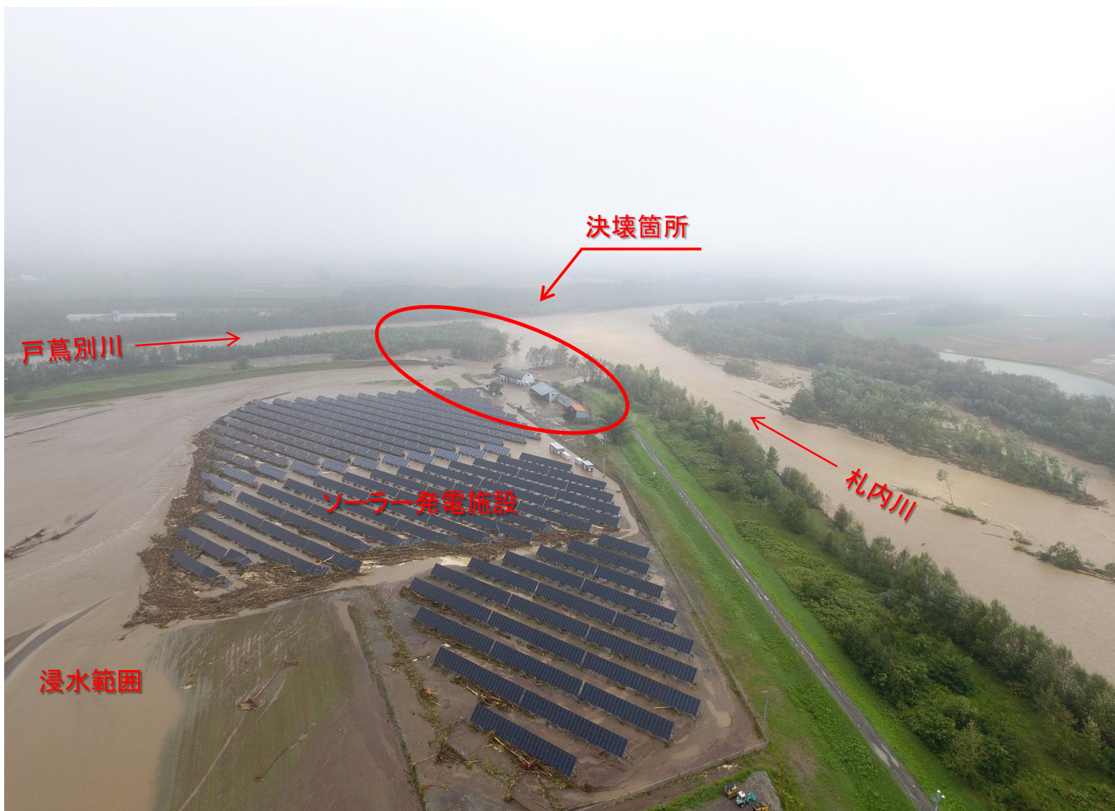
決壊箇所(ドローンによる空撮 8月31日 8:51撮影)
