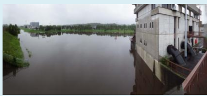
池田排水機場
