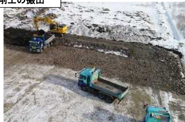
河川掘削土の搬出
