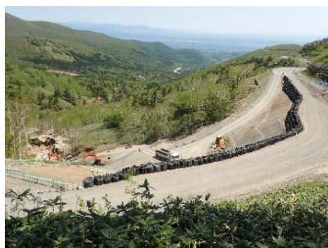
【平成29年6月14日 盛土工事中】
