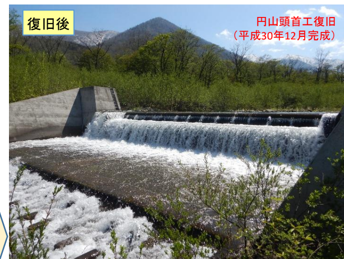
【御影地区】円山頭首工の現在（令和8年5月撮影）
