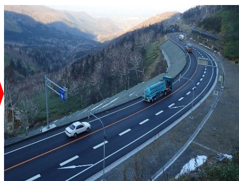
【平成29年10月20日 復旧工事完了】
