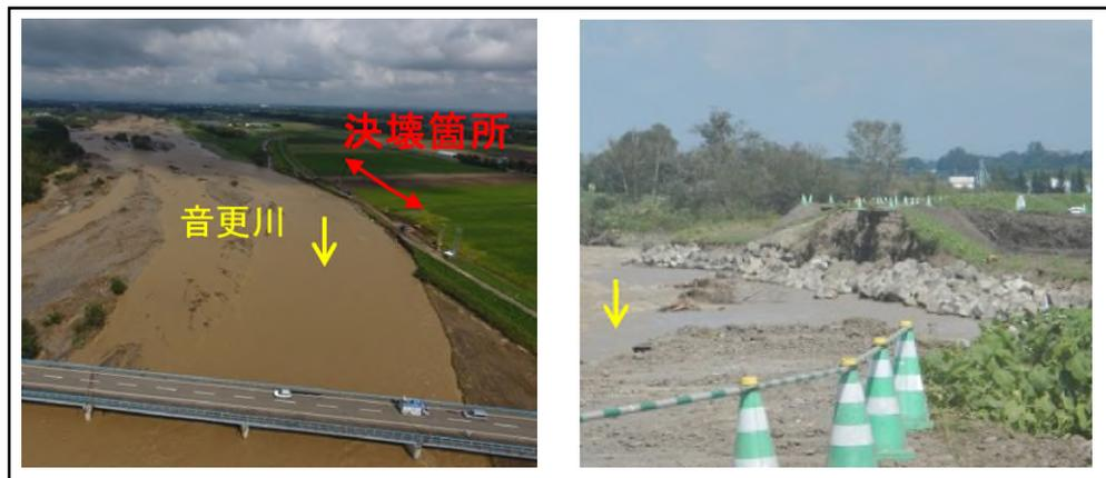
写真 5-2 堤防決壊箇所 (音更川 KP21.2 左岸)
