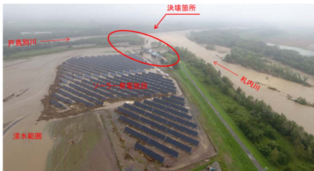
決壊後の状況
