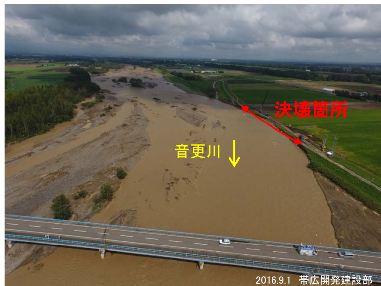
決壊後の状況
