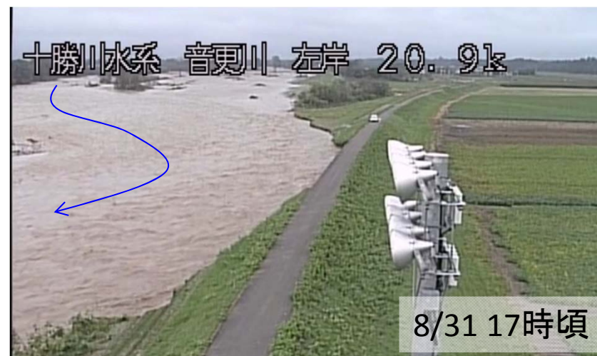
決壊箇所の状況
