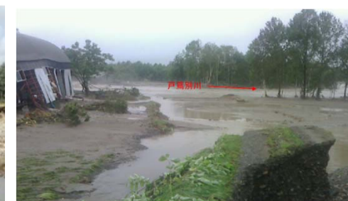
家屋等の被災状況
