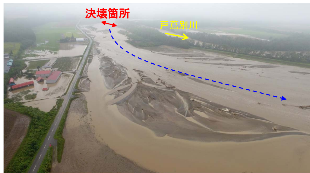
決壊後の状況
