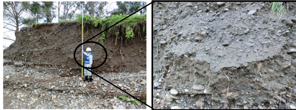
堤防断面（札内川寄り）（礫混じりの砂質の堤体、基盤に礫層）
