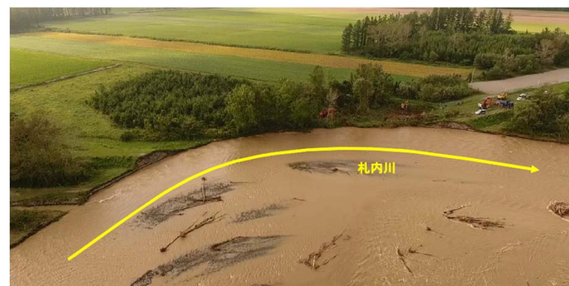
決壊箇所の状況(拡大)
