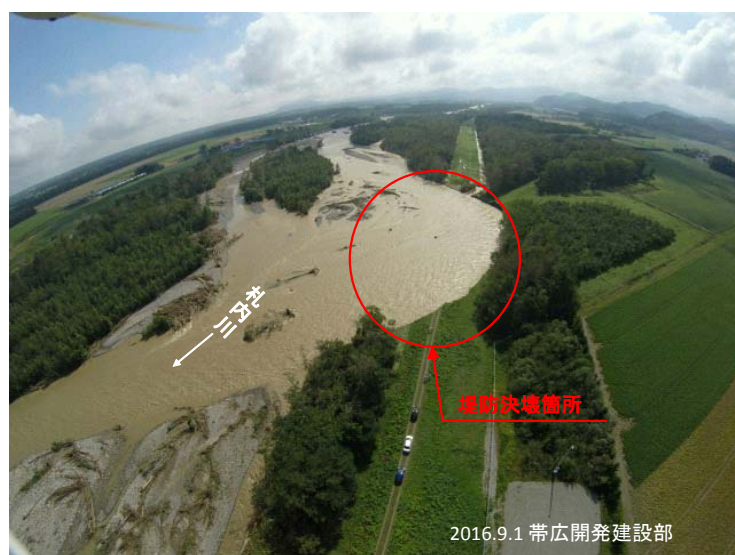
決壊後の状況
