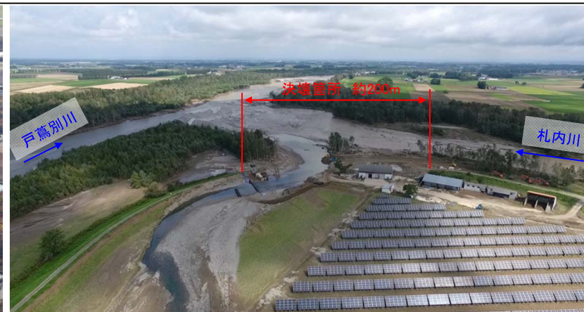
決壊箇所の状況
