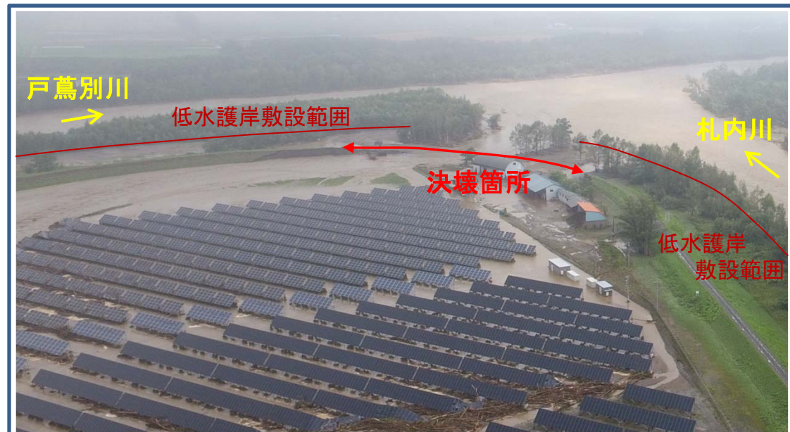
決壊後の状況
