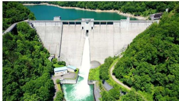
**札内川ダム** 洪水調節、流水のながい用水、水道用水の供給、発電を目的とした多目的ダムとして建設。114.4mの堤高は水系最大。
