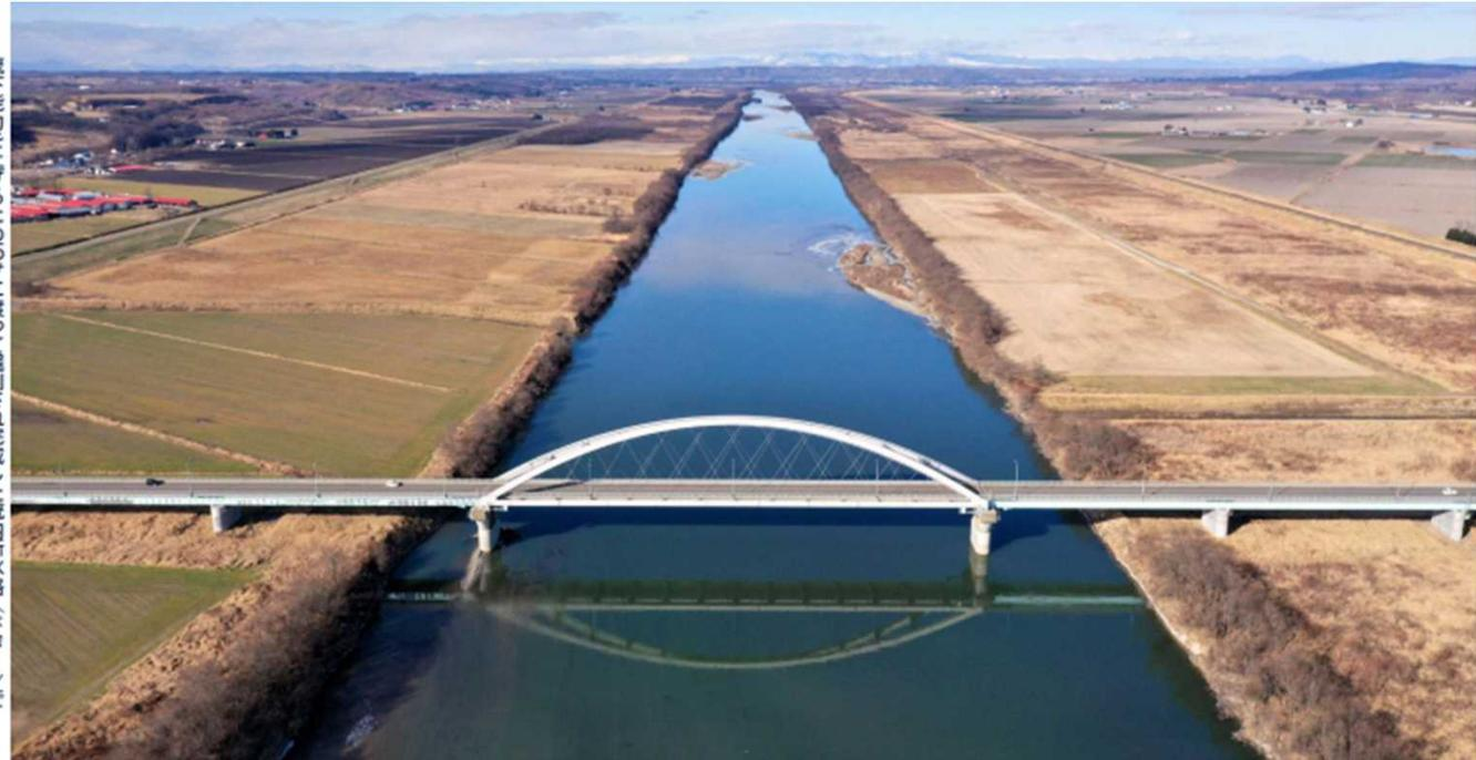
流下能力を上げるため15%に渡って掘削された統内新水路(ドローンで撮影)
