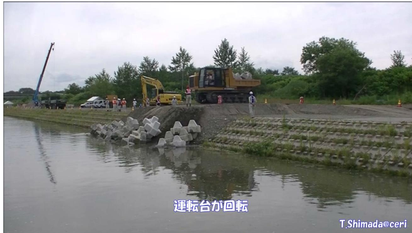
ダンプトラック及び不整地運搬車によるブロック運搬（H29年7月に千代田実験水路で行った実験の様子）
