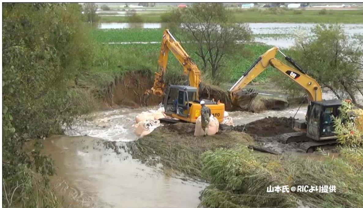
写真 1.17 大型土のうのバケツリレー
