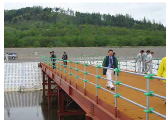
写真-4 下流側観測橋の視察状況
