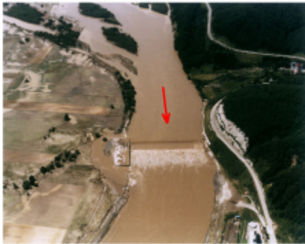
昭和56年8月の洪水災害で被災した千代田堰堤
