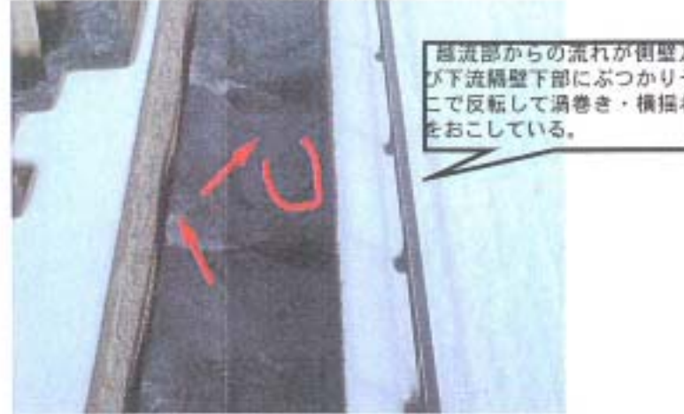
右岸魚道 (傾斜隔壁型) 下流部
