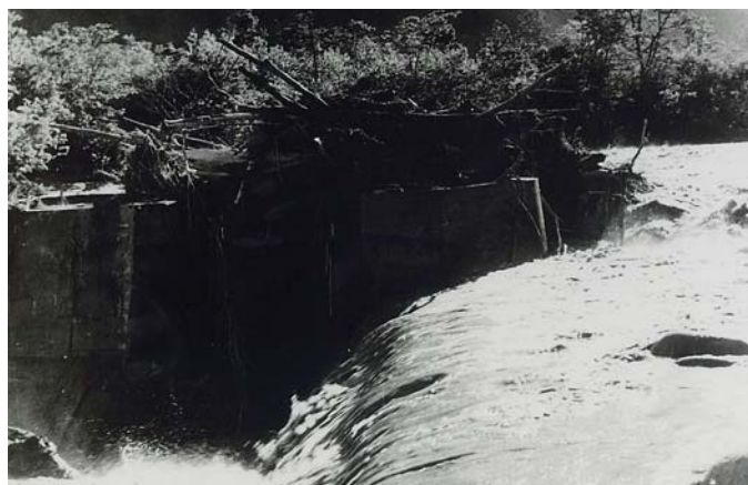
昭和30年(1955)、前の年にできたばかりの発電用ダムが、洪水による土石流でうまった。今のピョウタンの滝(札内川上流、中札内村)。
