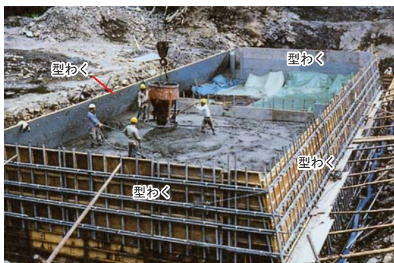
工事中の札内川第11号砂防えん堤（昭和54年《1979》）。型わくを組み立て、そこにコンクリートを流しこむ。
