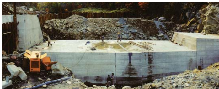
工事中の戸鳶別川第6号砂防えん堤（昭和52年《1977》）。
