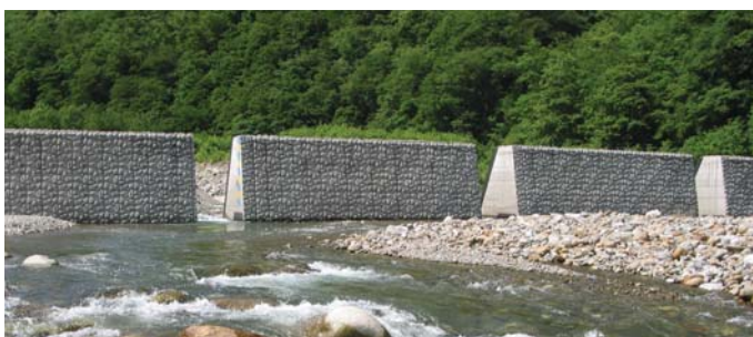
戸鳶別川第5号砂防えん堤には、すきま（スリット）がある。
