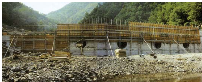
工事中の札内川第10号砂防えん堤（昭和52年《1977》）。
