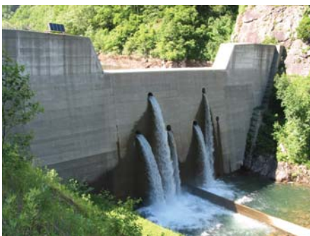
できあがった戸鳶別川第8号砂防えん堤。
