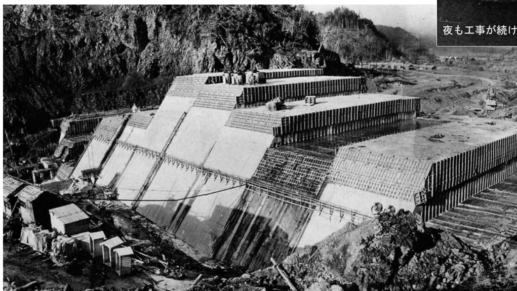
高さ76mに向けて、建設中の糠平ダム。
