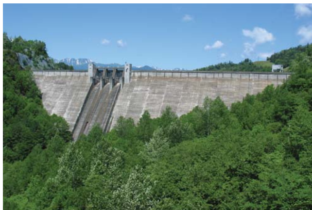
音更川上流にある糠平ダム(上士幌町)。
