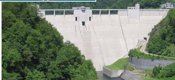
完成後の札内川ダム。左上はダムにためられた水。ダムにためることのできる水の量は、5千400万m 3 = 帯広市役所で約900杯分。
