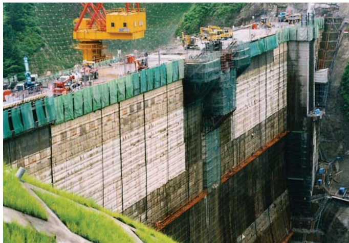
かなりダム本体ができてきた札内川ダム (平成7年)。完成後の高さは114m。
