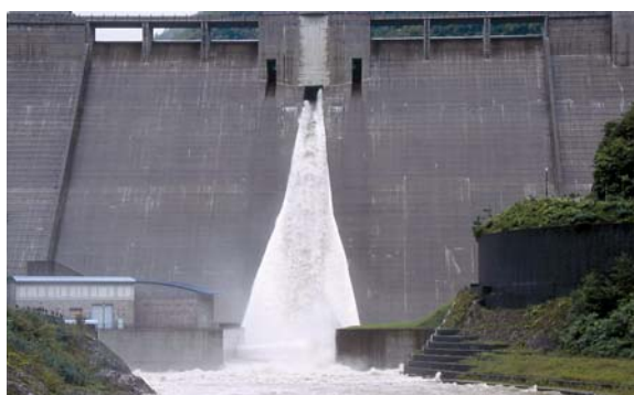
大雨の時洪水をおさえるために水をため、雨の量が少なくなって放流する札内川ダム。
