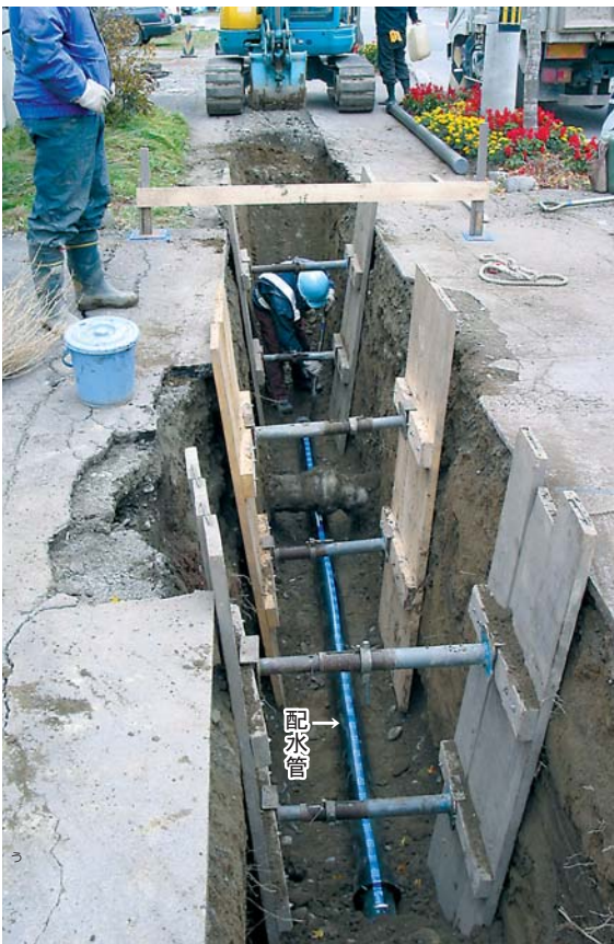
配水管などの水道管は、深く穴をほってうめられる。この管は「ダクタイル鋳鉄（→p31）」できている。
