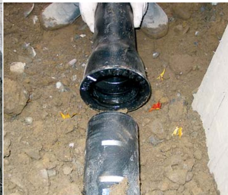
管をつなぐ。これは、はめこむタイプ。水道の管にはいろいろな大きさ、つなぎ方がある。
