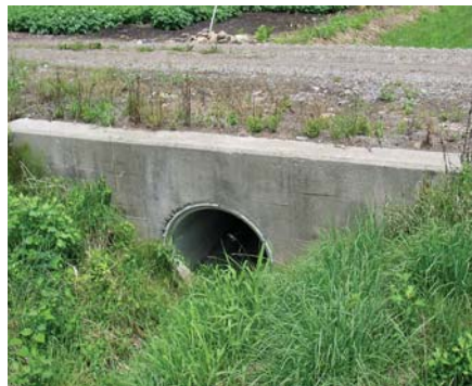
パイプカルバート。
