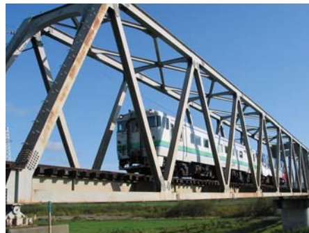
列車が通る第一十勝川橋梁（千代田の鉄橋）。
