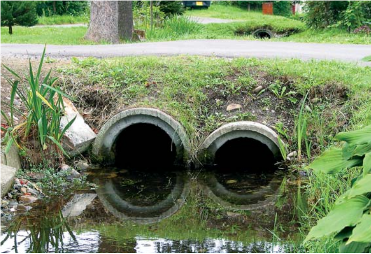
道の下を通るパイプカルバート。
