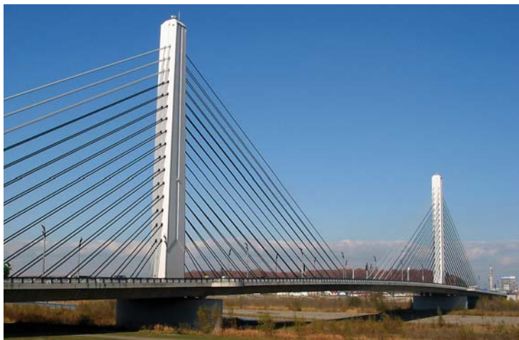
十勝川にかかる十勝大橋は、2つの主塔から斜めに張りわたした多くのケーブルで、橋げたをつっている「斜張橋」。
