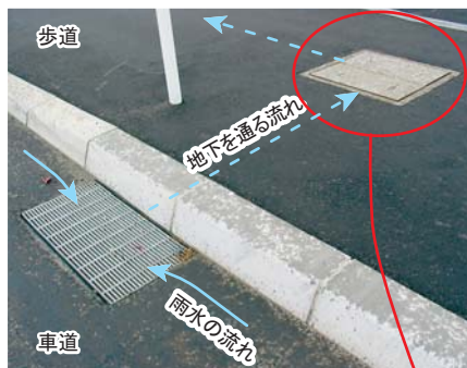
(上) 道のはしにあって、雨水が流れ込むあみ。この場合は、流れこんだ水が、歩道の下へ行く。
