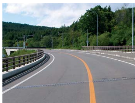
カーブしている居辺橋。
