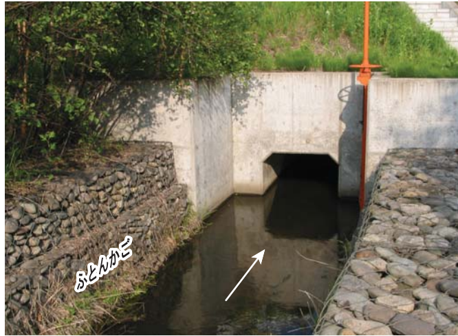
道の下をくぐる「トンネル」。地下の水路を「暗渠(※1)」とか「カルバート(※2)」と呼ぶ。わきに積んであるのは岸を守る「ふとんかご」。
