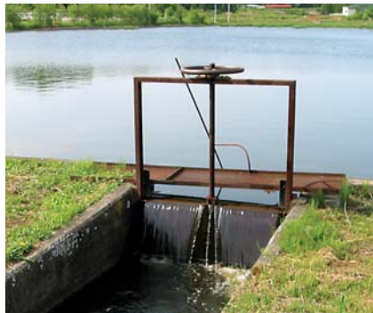
水の出口。水門 すいもん のようなものがあり、水はとびらの上から流れ落ちて水路に入る。
