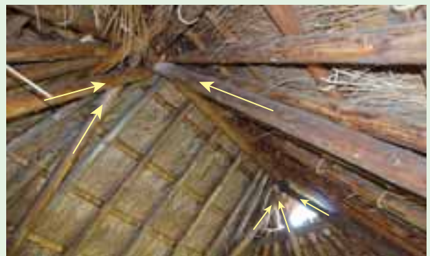
東泉園につくられたチセの、屋根の骨組み。手前とおく、それぞれに三脚のような丸太組みがある。(黄色の矢印)
