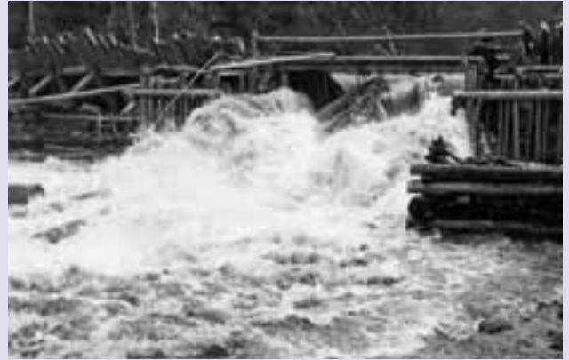
堤流。せきの水門を開いたところ。右はしに人がいるので大きさがわかる。(写真:本別町歴史民俗資料館蔵: 6)
