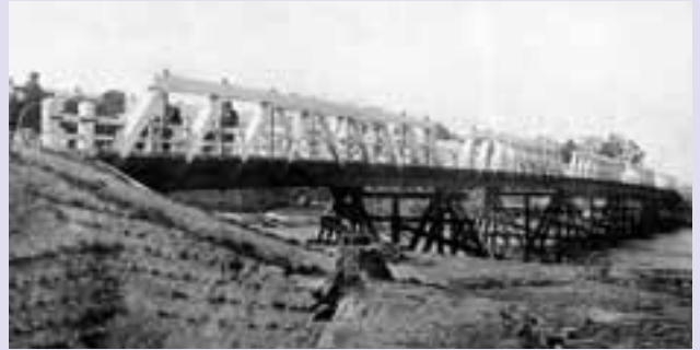
明治44年(1911)開通した河西橋。(写真:『十勝国産業写真帖』より)
