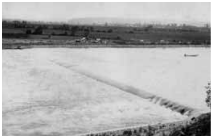
昭和10年(1935)完成した千代田堰堤。千代田や利別(池田町)の水田をうるおした。(写真:『十勝川写真で綴る変遷』より)
