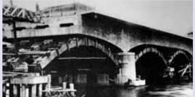
新しい河西橋(旧十勝大橋)の工事。(写真:『十勝川写真で綴る変遷』より)
