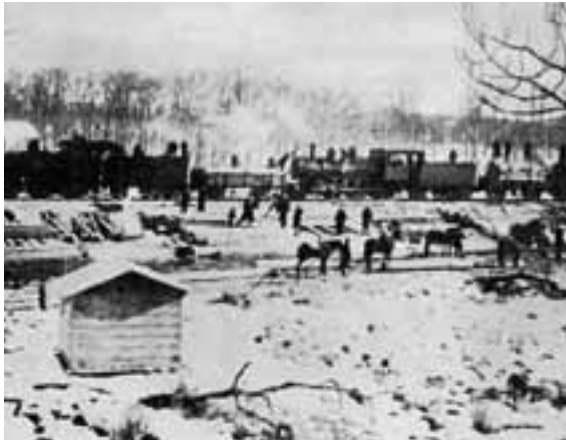
池田停車場構内の建設作業のようす。明治37年(1904)。(写真：『池田町懐かしのアルバム』より)
