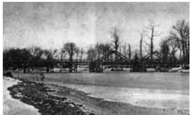
明治38年(1905)にかけられた開成橋。
