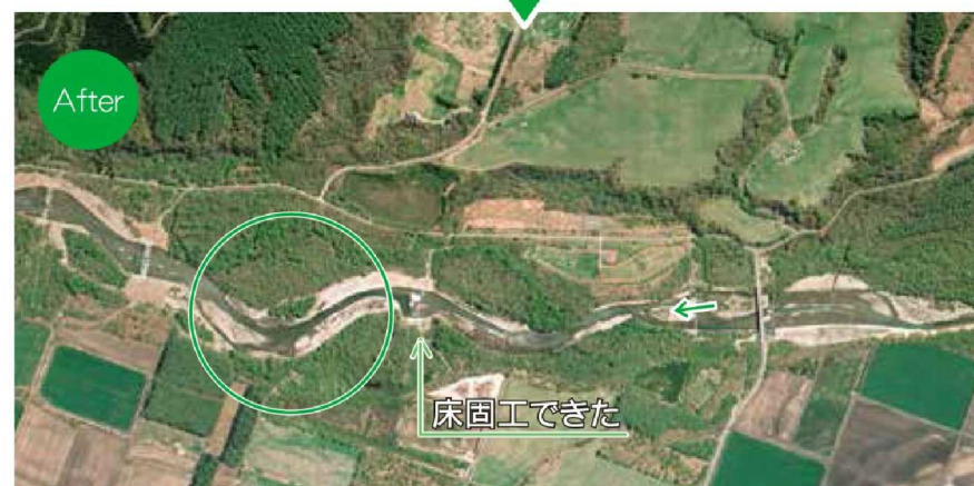
床固工群整備後 (垂直写真 平成21年)
