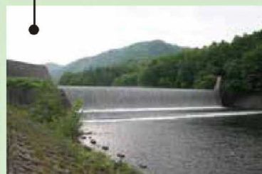
札内河第一号砂防堰堤
