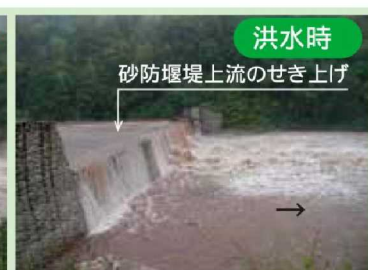
洪水時の透過型堰堤の状況
