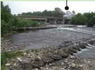
戸蔦別川第十五号床固工
