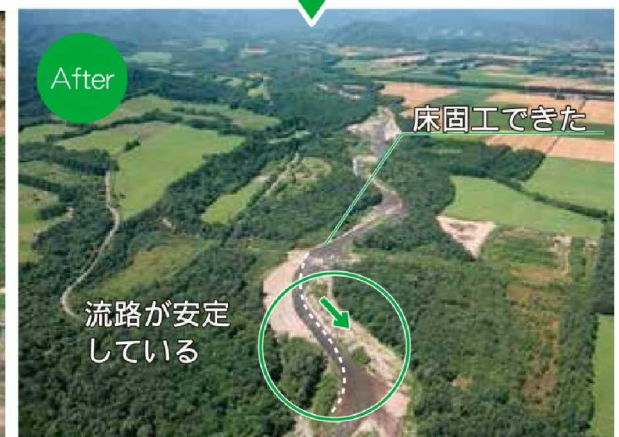
床固工群整備後 (平成21年)
