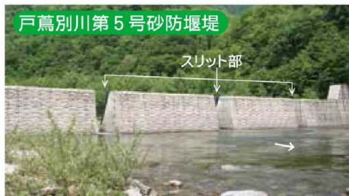
スリット型の砂防堰堤（平常時）
