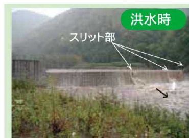
洪水時の透過型堰堤の状況
