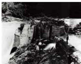
昭和30年 八千代発電ダムの被害
