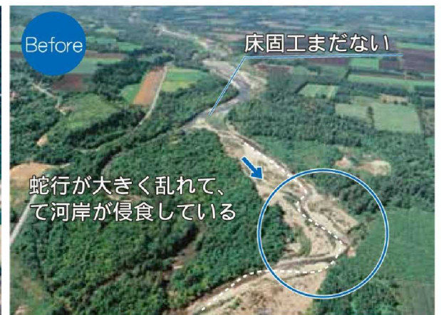
床固工群整備前
