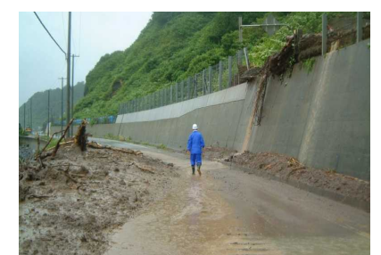
写真4: 平成22年7月豪雨時の 土石流による現道被災状況
