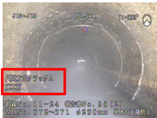
TVカメラによる管内の詳細調査
