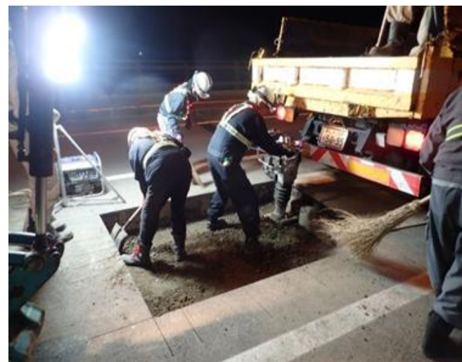
補修状況：国道12号（札幌市）
