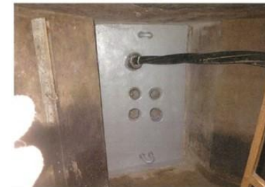
補修後（壁面補修）
