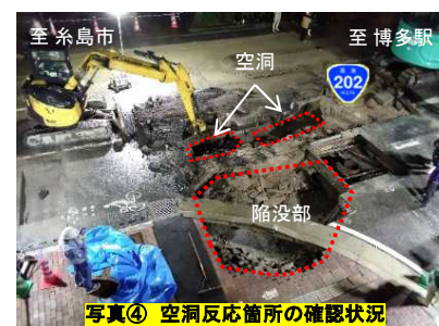
写真④ 空洞反応箇所の確認状況
