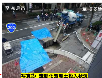
写真③ 流動化処理土投入状況
