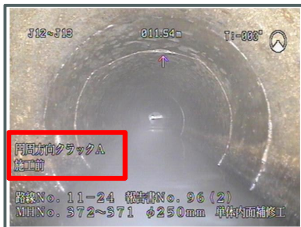
TVカメラによる管内の詳細調査
