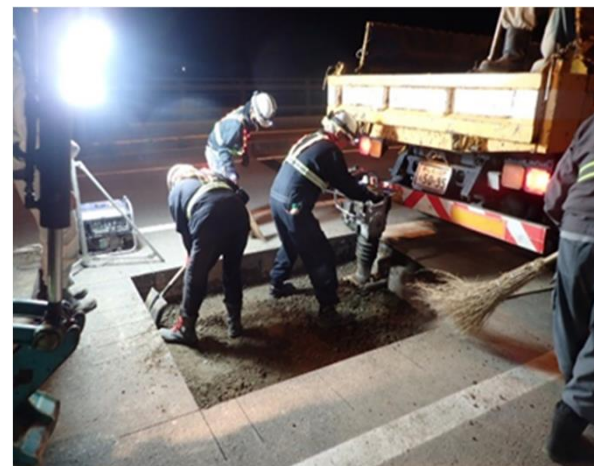
補修状況：国道12号（北海道札幌市）
