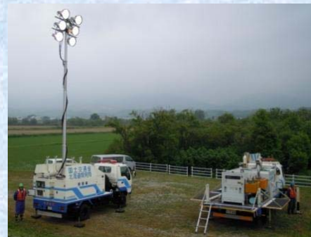
照明車と排水ポンプ車
