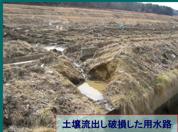
津波により表土・基盤土が流出した水田
