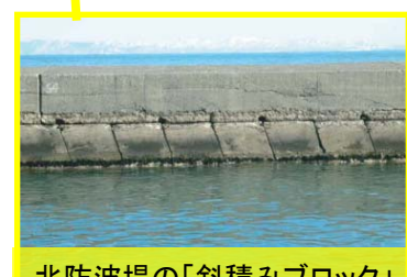
北防波堤の「斜積みブロック」
