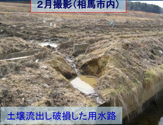
土壤流出し破損した用水路
