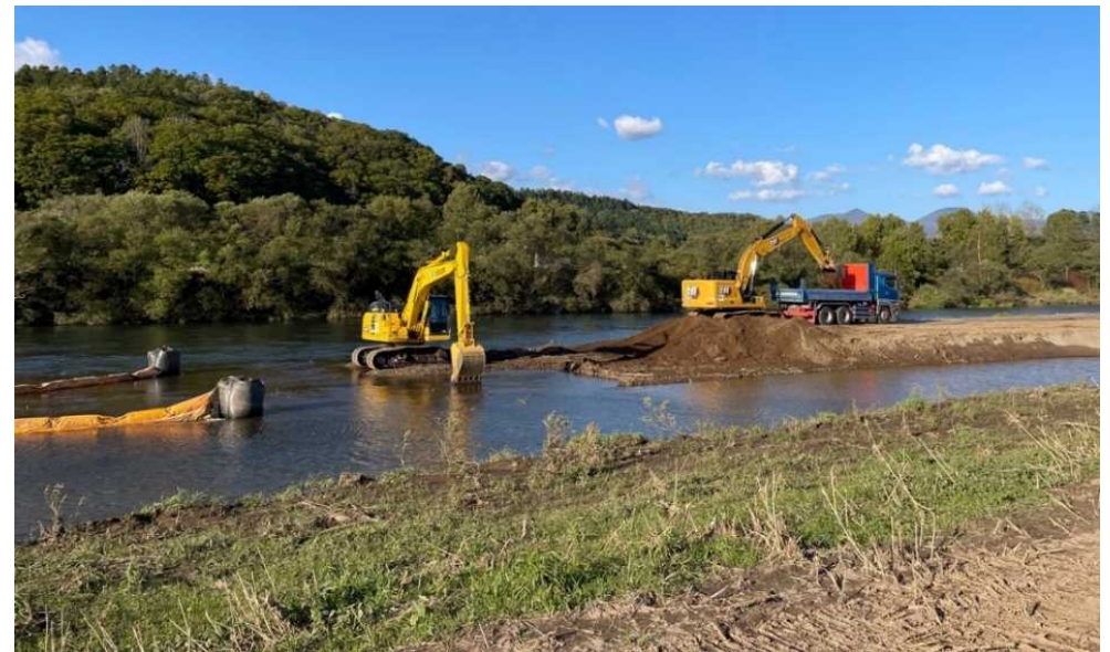
中州の掘削状況
