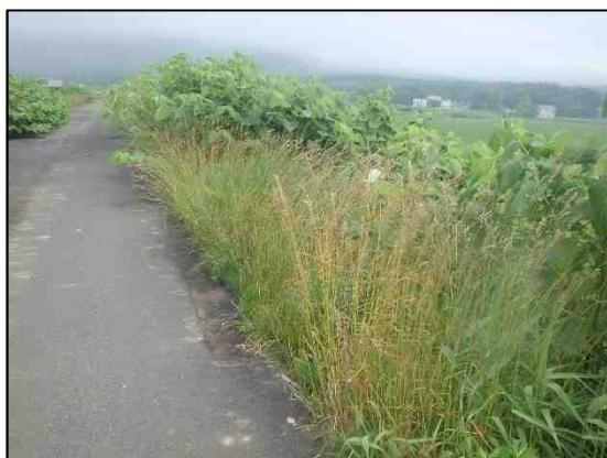
堤防法面（実施前）
