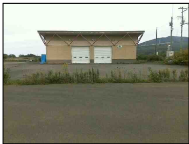
大曲資材備蓄基地
