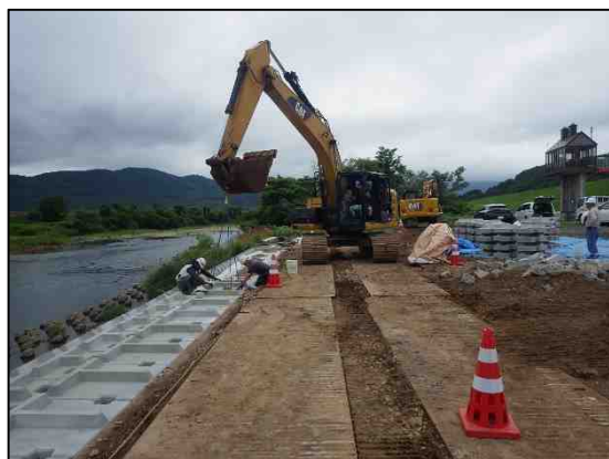
護岸補修（栄浜護岸）
