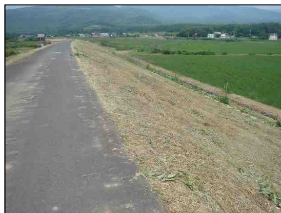
堤防法面（実施後）
