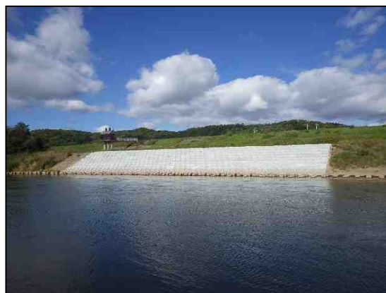
護岸補修（栄浜護岸）
