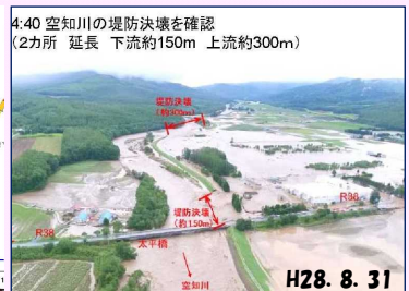
4:40 空知川の堤防決壊を確認 (2カ所 延長 下流約150m 上流約300m) H28. 8. 31 空知川(南富良野町幾野地区)の堤防決壊 市街地や農地が浸水し甚大な被害発生
