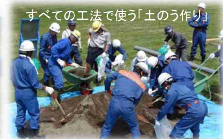
洪水が堤防を越えるのを防ぐ「積み土のう工」
