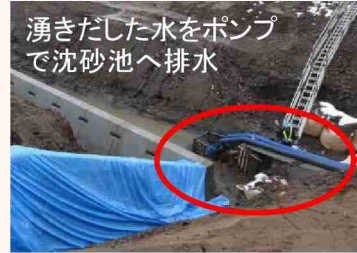
沈砂池で泥を沈殿し、うわ水を川に流します
