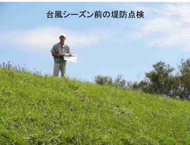
台風シーズン前の河川管理施設の点検
