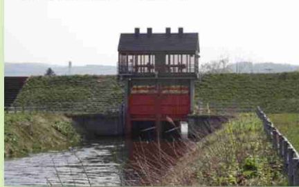
樋門(旧蘭越1号樋門)
