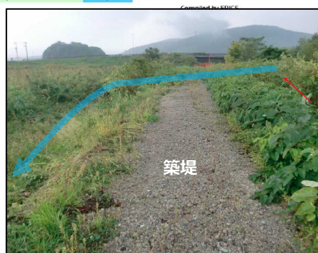
SP9950付近 堤防溢水痕跡
