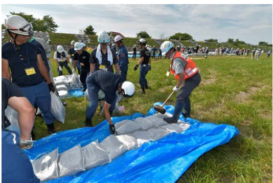
積土のう工（杭省略型）
