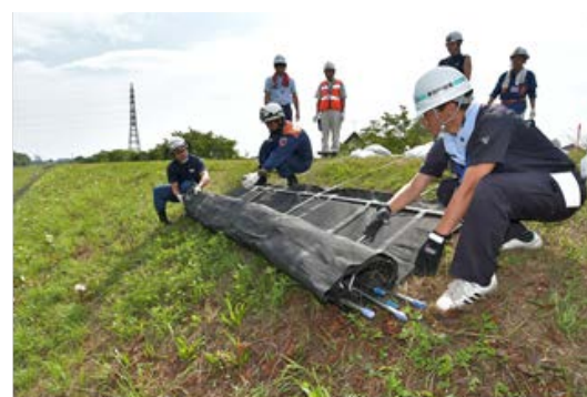
シート張り工
