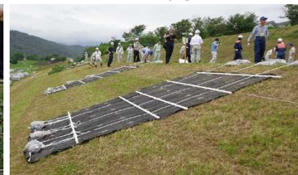
シート張り工
