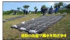
シート張り工の設置状況
