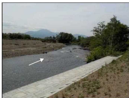
尻別川(倶知安町寒別地区) 護岸工
