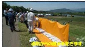
改良積み土のう工の設置状況
