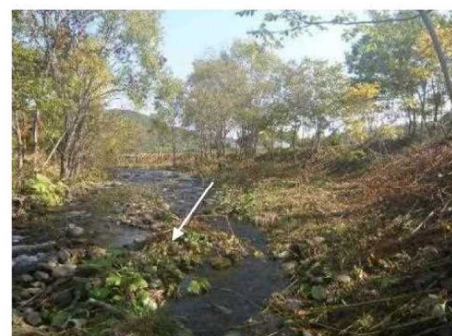
ルベシベ川（ニセコ町宮田地区） 護岸工
