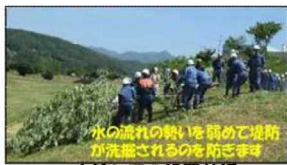
木流し工の設置状況
