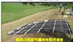
シート張り工の設置状況
