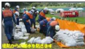
改良積み土のう工の設置状況
