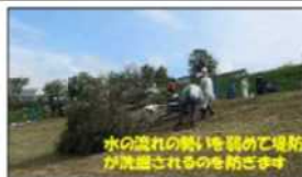
木流し工の設置状況
