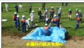
月の編工の設置状況
