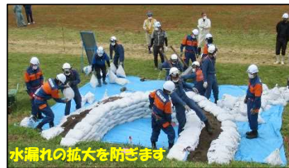
月の輪工の設置状況
