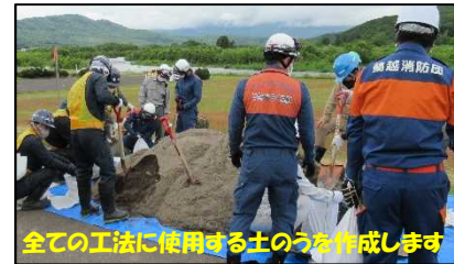
土のう作り工の作業状況
