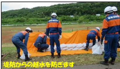
改良積み土のう工の設置状況
