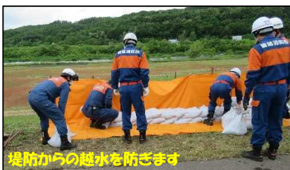
改良積み土のう工の設置状況
