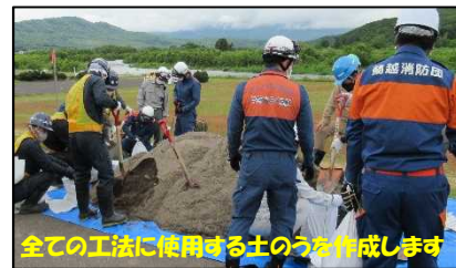
土のう作り工の作業状況
