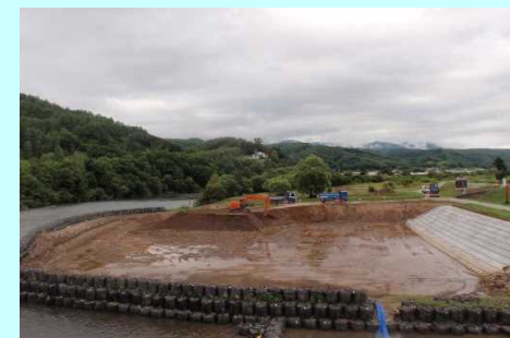
河道掘削工事（継続実施）
