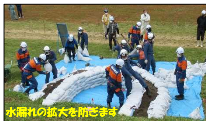
月の輪工の設置状況
