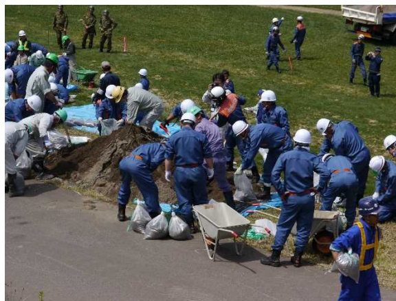
蘭越町水防工法実技訓練 (平成27年6月12日実施)
