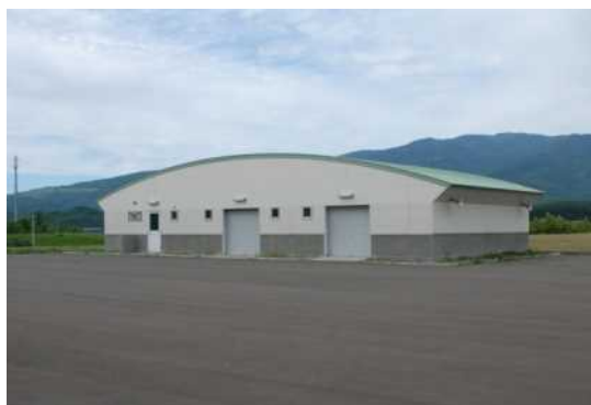
水防資材倉庫
