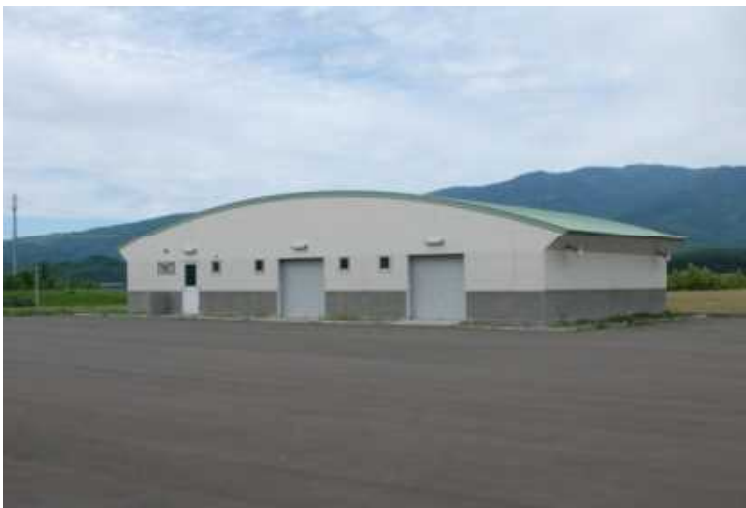
水防資材倉庫
