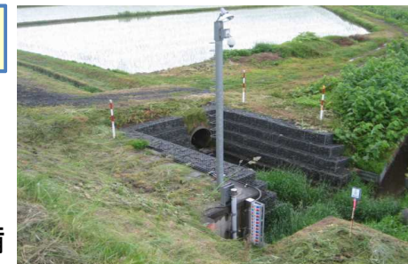
樋門釜場の整備
