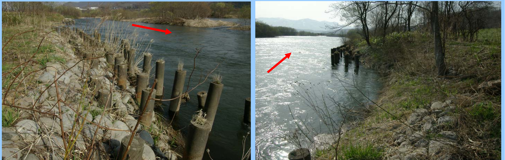
河岸保護工事（H19施工）施工後1年経過
