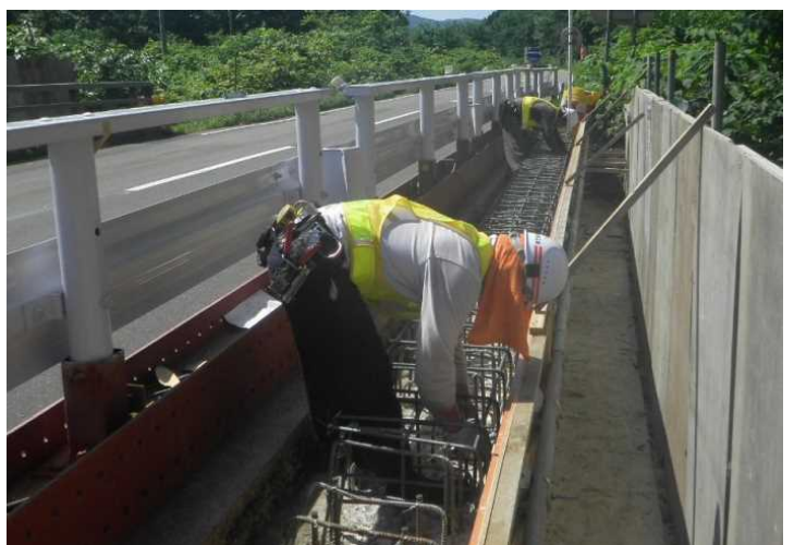
地覆の補修状況
